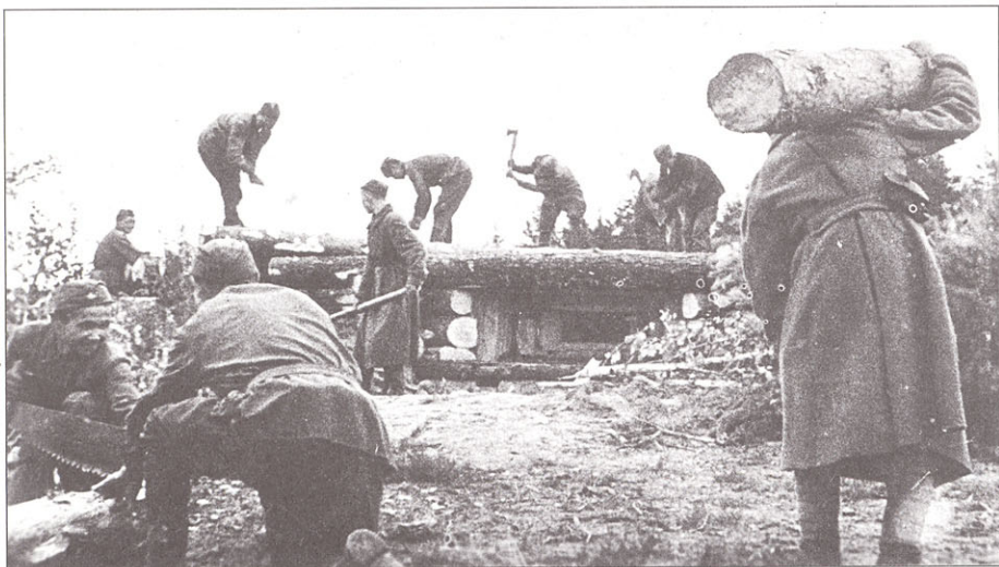
Сооружение ДЗОТа в полевых условиях
