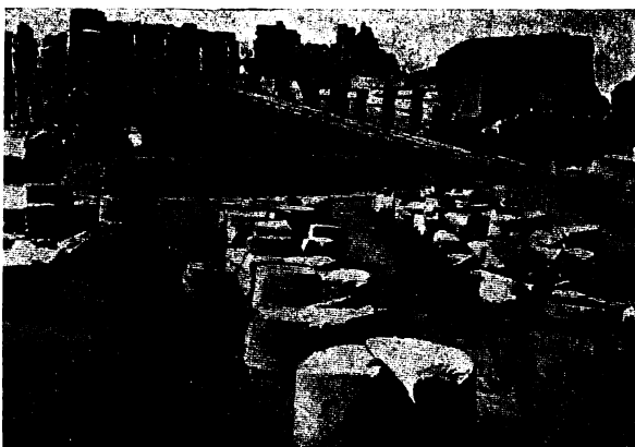
1. Наклонная насыпь для разборки колоннъ.
