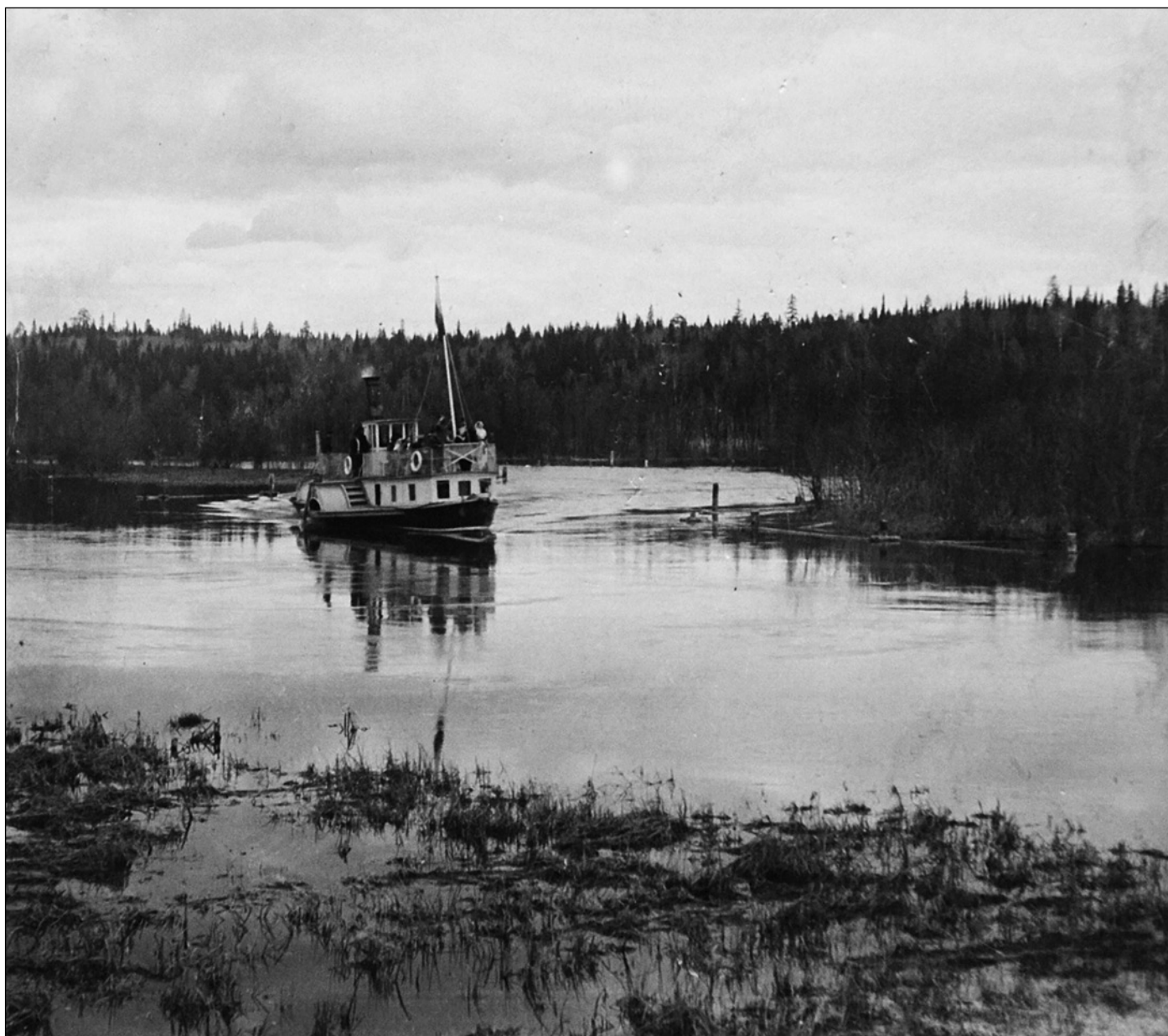
Пароход «Иж» в верховьях Ижевского пруда. Показан вид парохода, доработанного по опыту эксплуатации первых лет. Появилась капитанская рубка. Фото из коллекции О.В. Севрюкова (ЦГА УР. Ф. 1539, оп. 2. Д. 297/2)
