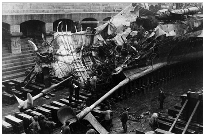
«Мэнли» в доке Ливерпуля. Хорошо виден характер разрушений, вызванный взрывом глубинных бомб
