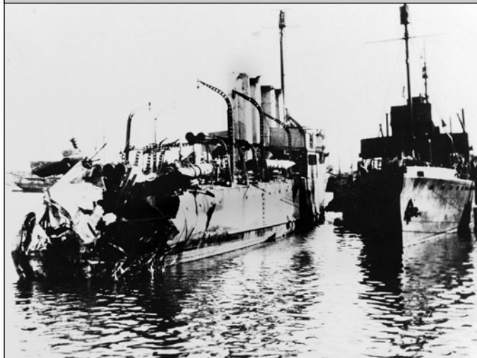
«Мэнли» 19 марта 1918 г., вскоре после взрыва глубинных бомб (вверху) и после буксировки в порт и осушения части затопленных помещений (внизу)
