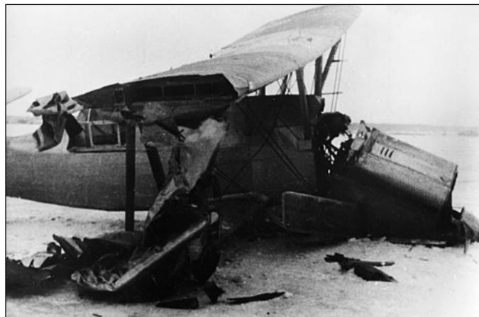
Авария второго опытного экземпляра ЛР 27 января 1934 г.
