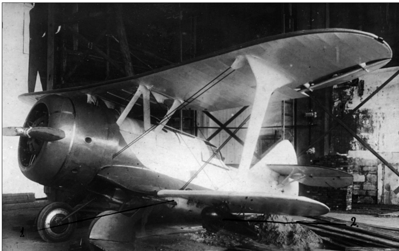
Первый опытный ДИ-6Ш, вооруженный четырьмя пулеметами ПВ-1.
