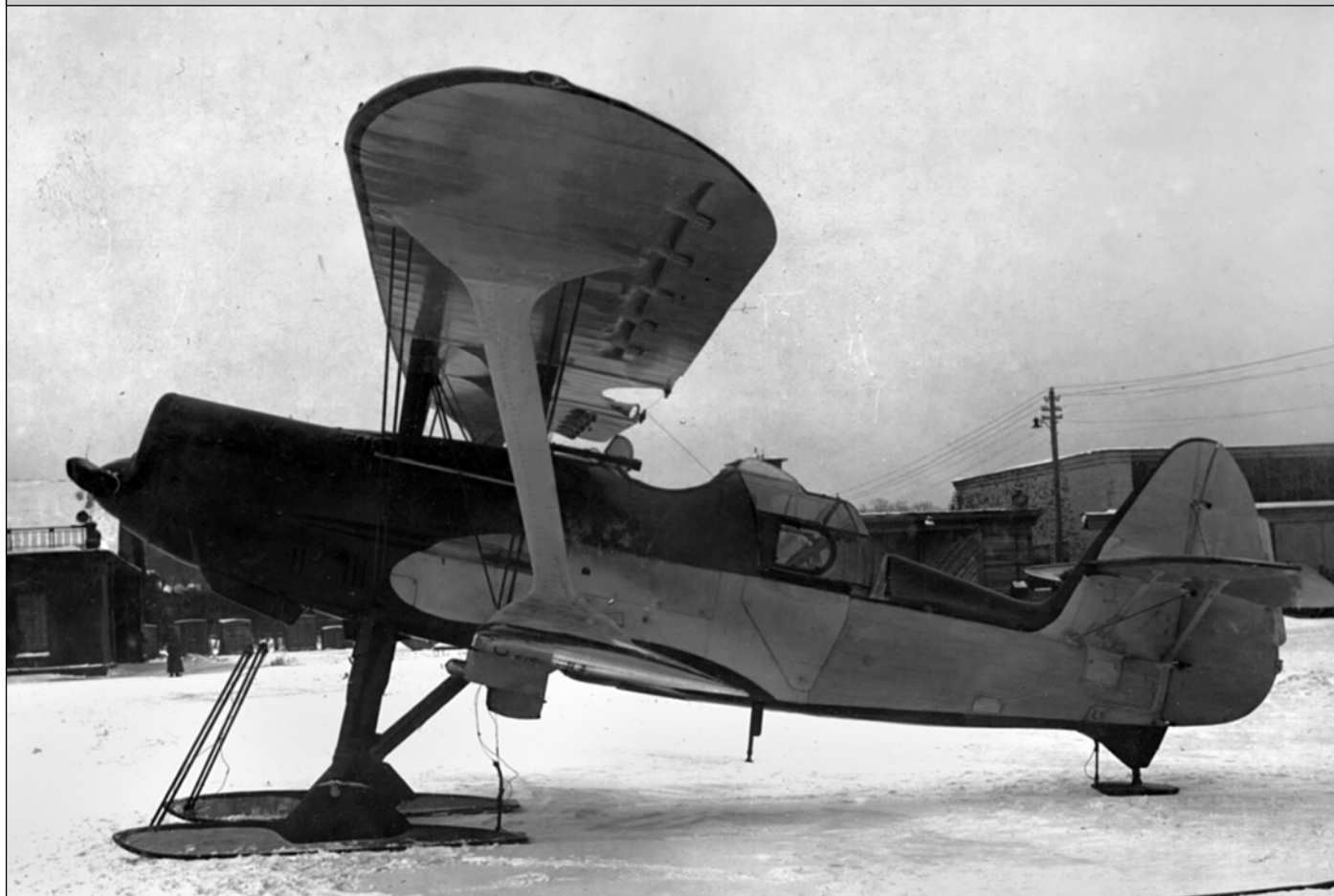
Первый опытный экземпляр на лыжном шасси в правой части (северо-западной) Ходынского аэродрома. На втором фото видно, что самолет стоит у знаменитого железобетонного ангара (здесь когда-то собирали триплан «Комта»). Зима 1933-34 гг.
