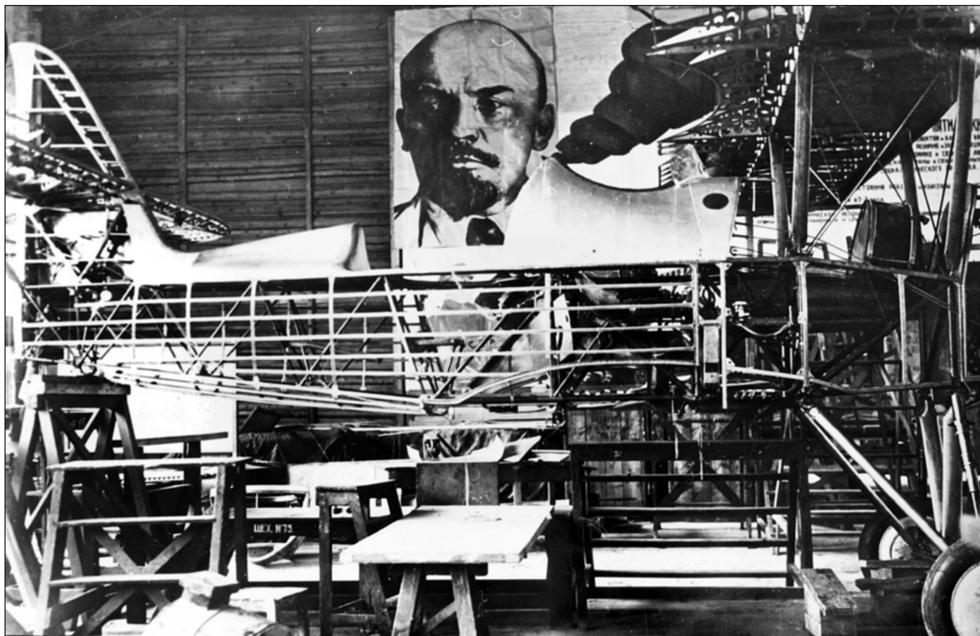
ЛР в процессе окончательной сборки до установки полотняного покрытия. Лето 1933 г. Наиболее вероятно сборка ведется в том самом цехе, когда то построенном Франческо Моска
