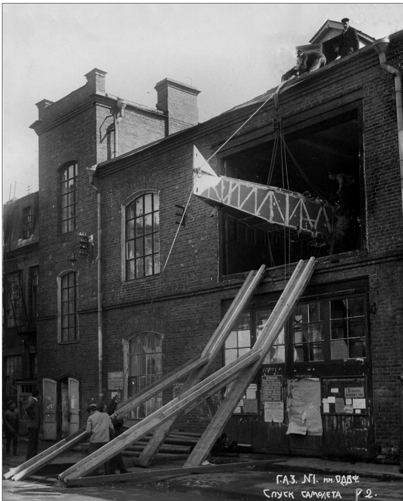
Спуск самолета Р-2 из помещения сборки на ГАЗ№1. Этот снимок – один из немногих, иллюстрирующих строения авиа-завода, на котором начинал свою деятельность С.А.Кочеригин. Очевидно, что запечатленное место находится совсем не задворках предприятия, а даже одно из основных – об этом свидетельствуют многочисленные объявления, размещенные на специальном щите
